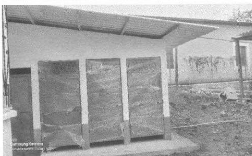
Foto 9: Aspecto final de pared sustituida del módulo 4.
