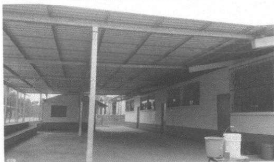
Foto 3: Aspecto del módulo 2. Una vez finalizado el mismo.
