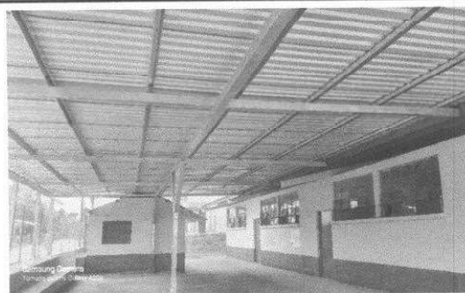
Foto 4: Aspecto final del módulo 2. realizado con estructura metálica.
