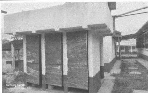
Foto7: Aspecto final del módulo 4. Tras la sustitución de puertas y aplicación de pintura.
