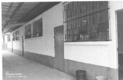
Foto1: Fachada exterior del módulo 1. Finalizada la aplicación de la pintura.
