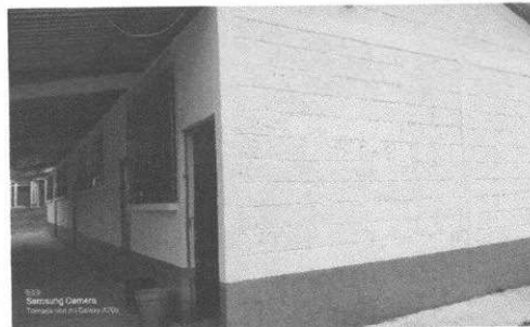
Foto 2: Pintura exterior e interior del módulo 1. Se aplicó para mejorar aspecto y vida útil a paredes.
