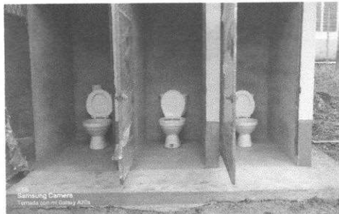
Foto 8: Aspecto final de la losa sanitaria instalada en el módulo 4.
